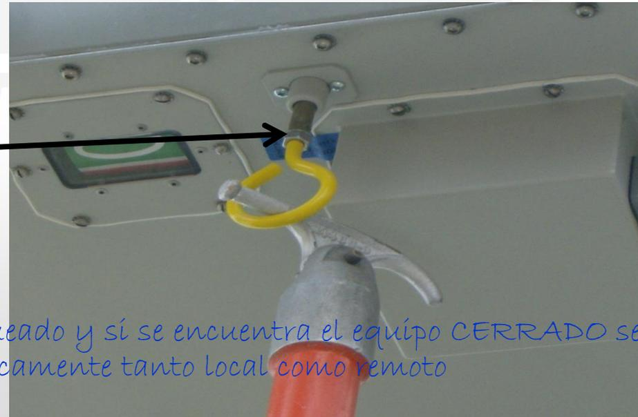
NOTA: Al posicionar la perilla en posición bloqueado y si se encuentra el equipo CERRADO se ABRE y queda bloqueado mecánicamente tanto local como remoto
